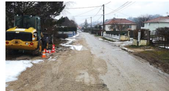
Les travaux d'assainissement de la rue de la Source.
