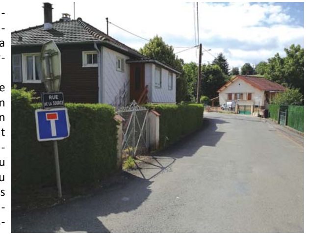
Travaux d'assainissement sur la rue de la Source.
