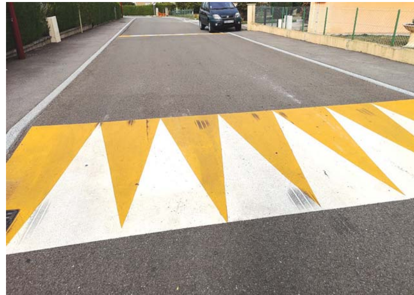
Au Parc Japy, une plateforme surélevée a été mise en place rue du Chenêt.
