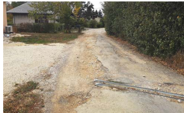
Des travaux nécessaires et sans doute très attendus...
