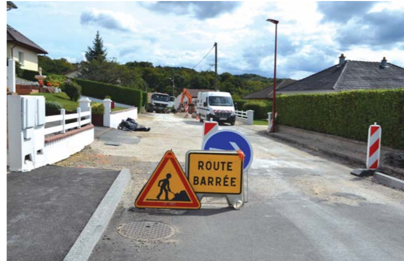
Les travaux actuels se déroulent sur la partie haute de la rue du Chenêt.
