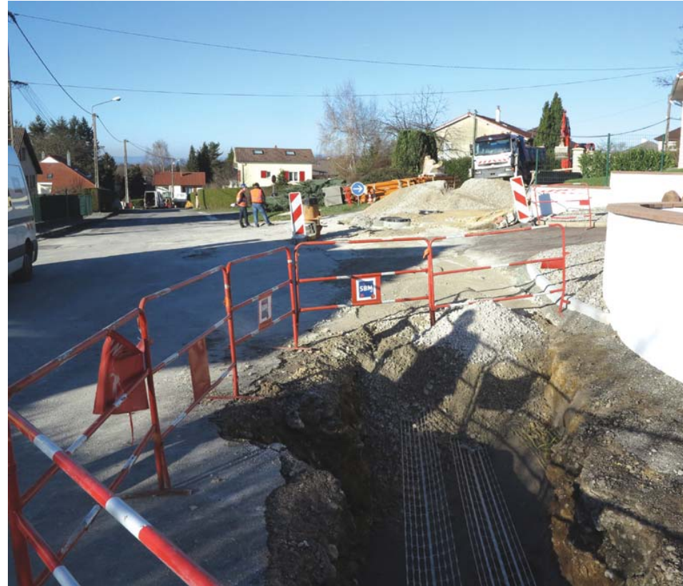
Les travaux se poursuivent au Parc Japy.
