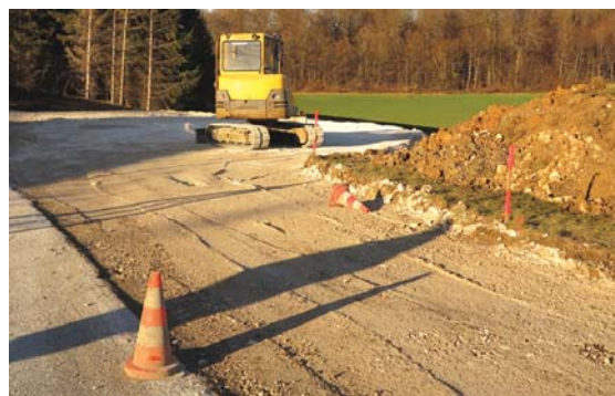
La plateforme en cours de réalisation.
